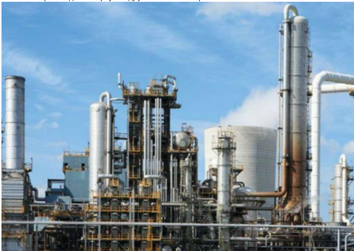
Слика 10. Производна постројења друштва ХИП Азотара
