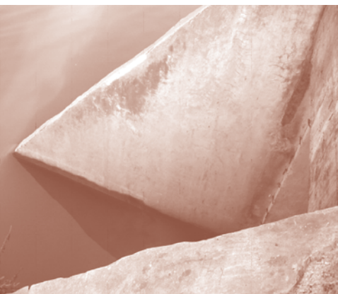
Испуст кишне канализације у реку Тамиш
