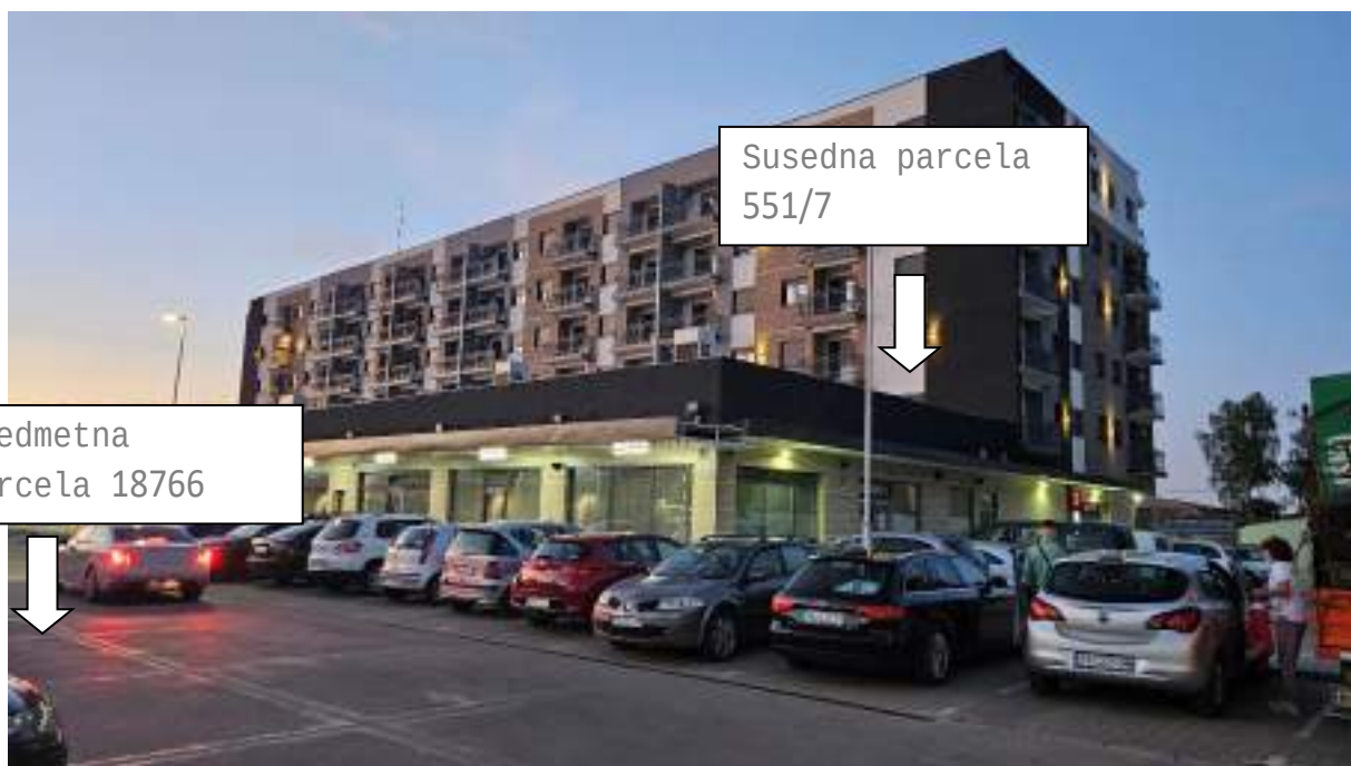
Pogled iz ulice Novoseljanski put na kat. parcelu br.18766 i 551/7 K.O. Pančevo
