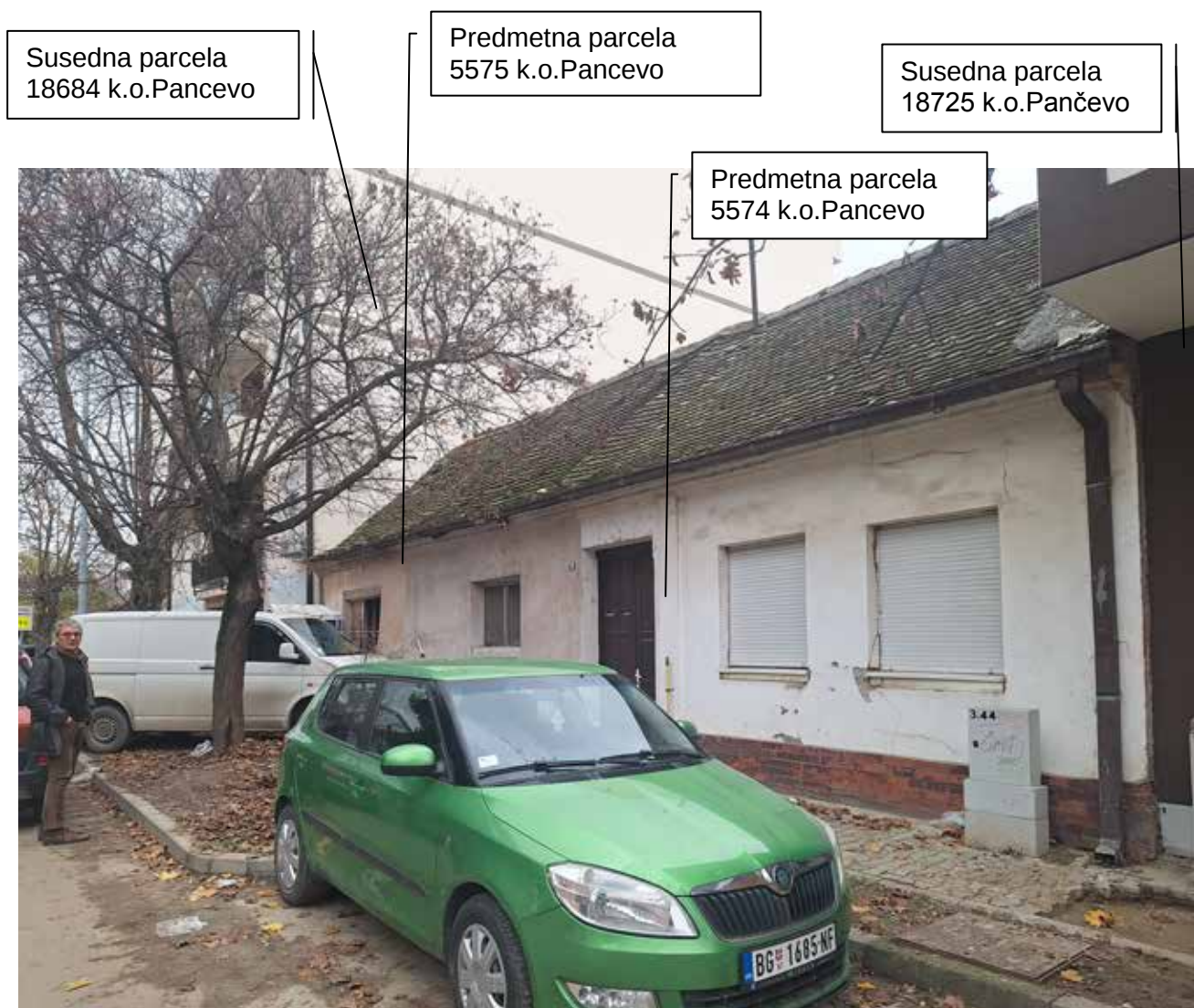
Pogled niz ulicu na predmetne kat.parcele 5574; 5575 k.o.Pančevo I ulicu Cara Dušana
