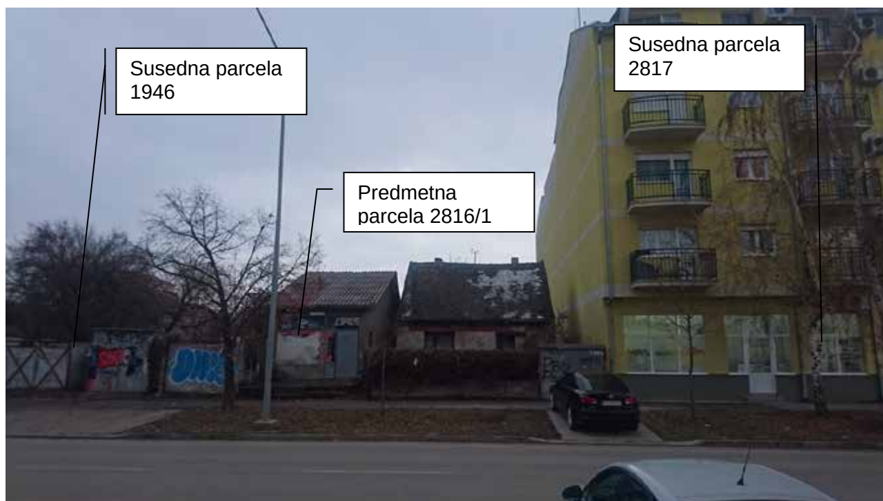
Pogled na postojeću parcelu iz ulice Svetozara Miletića
