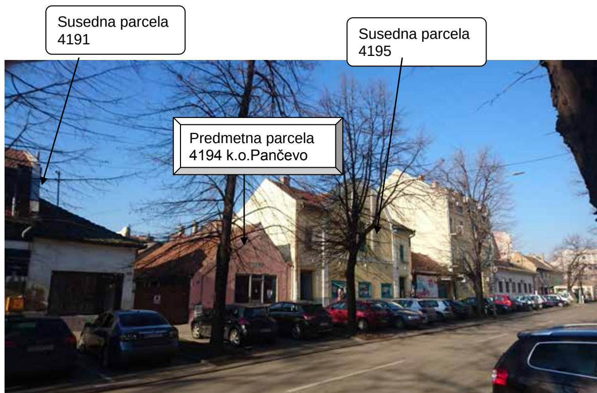
Pogled na ulicu Maksima Gorkog na susedni objekat „Apolo“ i predmetnu parcelu
