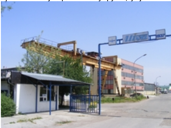
-Прилаз индустријском комплексу-
