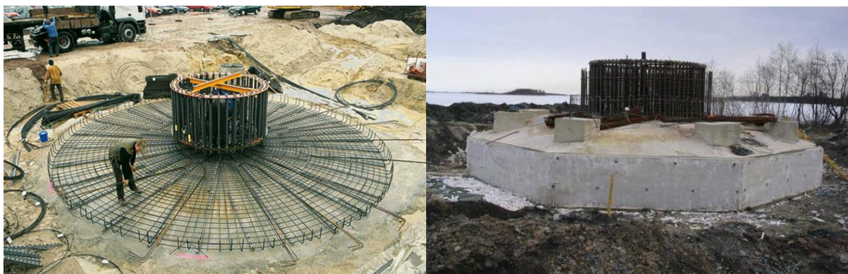
Слика 3.1. Примери темељења стубова ветротурбина
