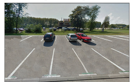
МОНТАЖА НОВОГ ПАРКИНГА
